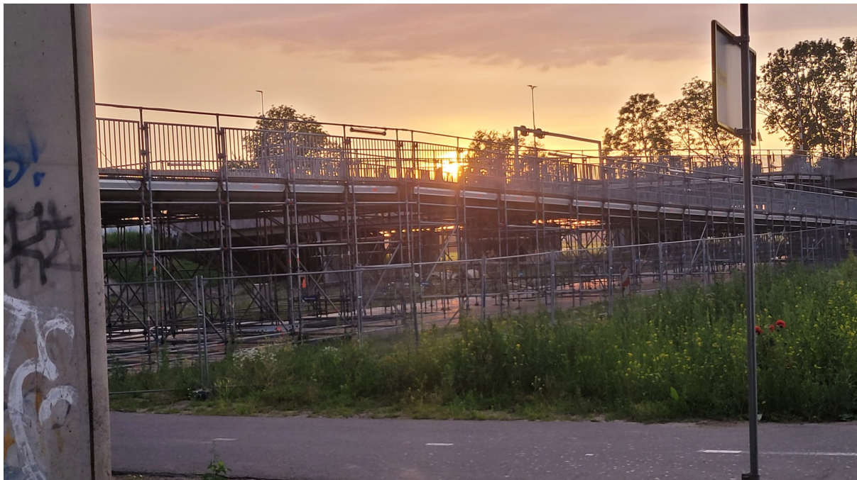
De tijdelijke fietspaden op steiger constructies waarvan er aan de overkant nog één stond
